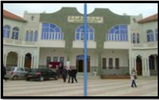
Figure 4_47: La symétrie au niveau de façade (Source : auteur )
