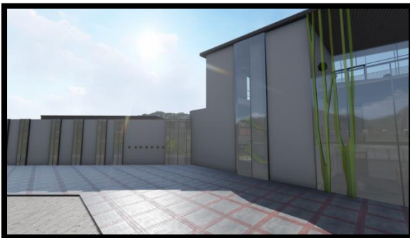
Figure 7_19 : vue extérieure (Source auteur)
