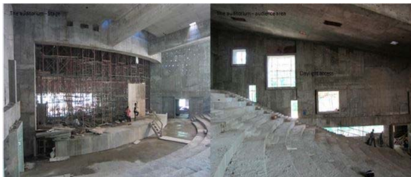
Fig.II.25. Le projet en construction
