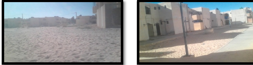
Figure 45: Des espaces négligé entre les logements
