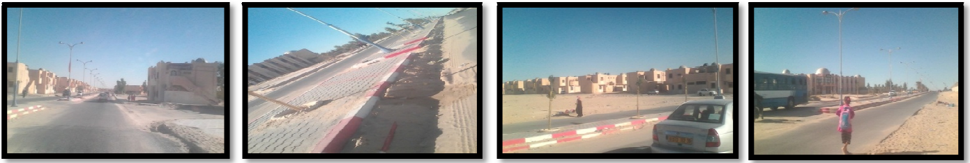
Figure 48: l'absence de l'aménagement du voie principale
