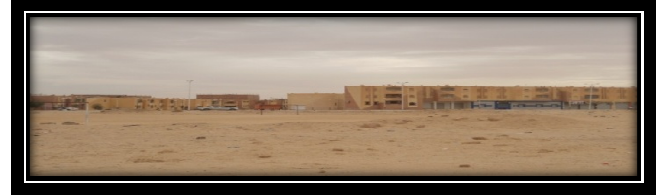
الصورة (20) الواجهة الجنوبية
