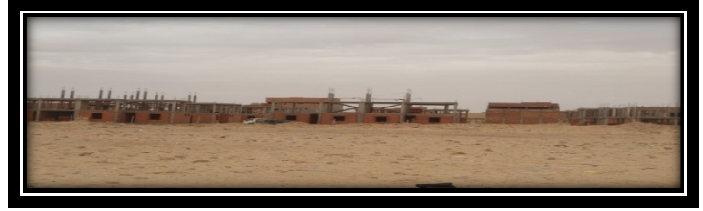
الصورة (19) الواجهة الشمالية
