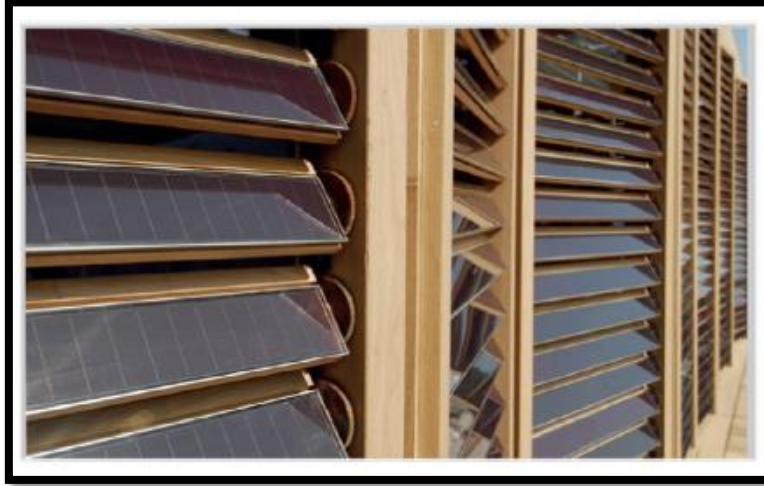
الشكل رقم (33) صورة توضيحية لدمج الخلايا الكهروضوئية في الغلاف المعماري
