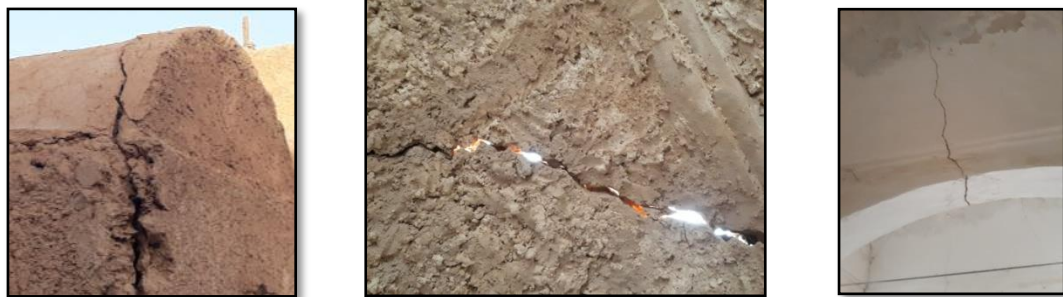
الشكل 102: بعض الصور تظهر التشققات الموجودة على الأقواس والسقف..
