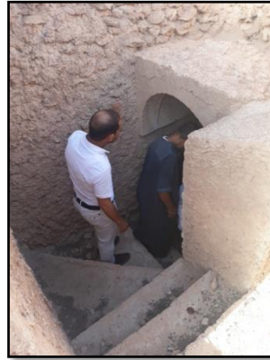
الشكل85: صورة لسقف سلم السطح.
