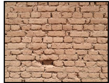
الشكل 8: صورة توضح طوب الطيني شتمة القديمة
