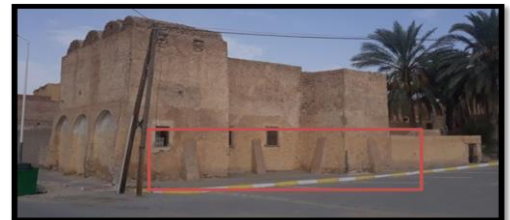
الشكل 46: صورة للمعلم بعد إضافة الدعامات المصدر: الباحث 2019م
