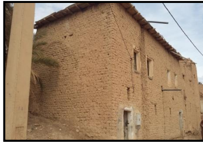
الشكل 9: صورة توضح منزل من الطوب الطيني شتمة القديمة
