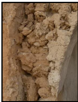
الشكل87 : صورة للجدار مكون من اللوس و الجبس .
