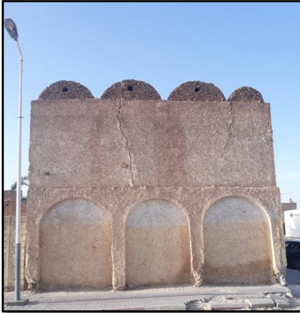
الشكل60 : صورة للواجهة الجنوبية للمعلم .
