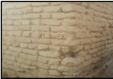
الشكل 10: صورة توضح طوب الطيني الذشرة قديمة ليشانة
