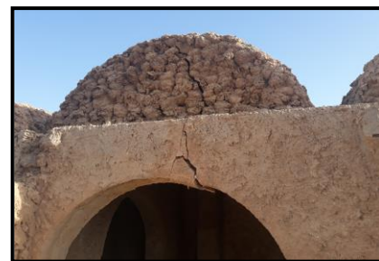
الشكل 17: صورة للمعلم توضح حجر اللوس على مستوى عقود
