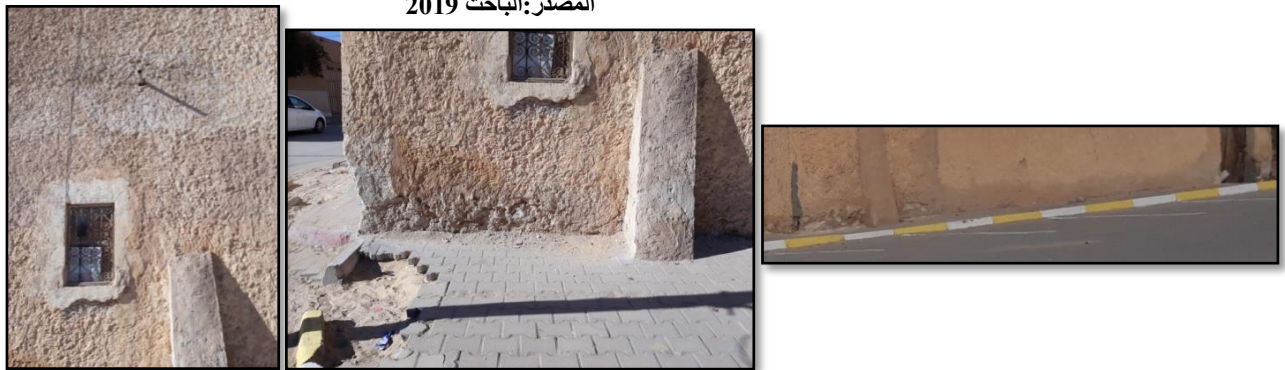
الشكل 93 : صور توضح الامراض الرطوبة الموجودة في الواجهة الشرقية للمعلم .
