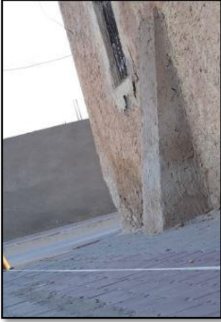
الشكل 122: صورة لشكل الدعامة المقترح إضافتها في واجهة الجنوبية.
