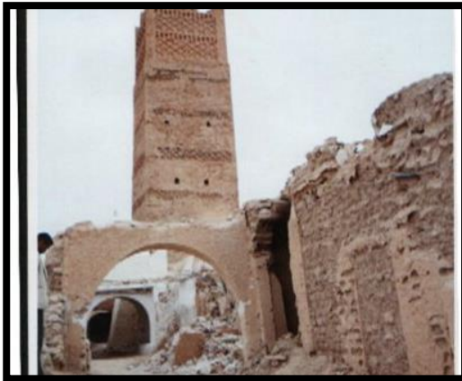
الصورة 8: مدخل الخوخة غربا
