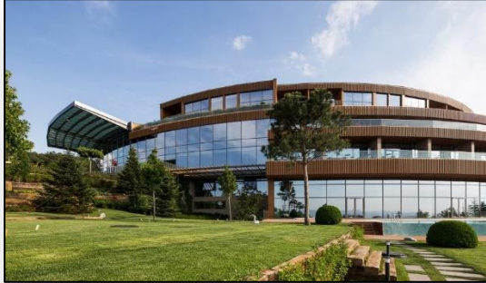
الصورة 98: واجهة فندق طاسيجو اسكسهير تركيا استعمل فيها مادة الزجاج المصدر : www.archdaily.com
