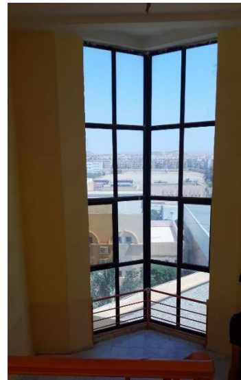
شكل 19,1 : يوضح نافذة عادية للمبنى
