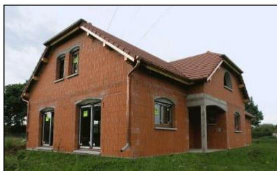
**Figure I. 06 :** L'enveloppe en remplissage maçonné
