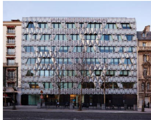
Figure 10: la façade de siège de Barclays à paris
