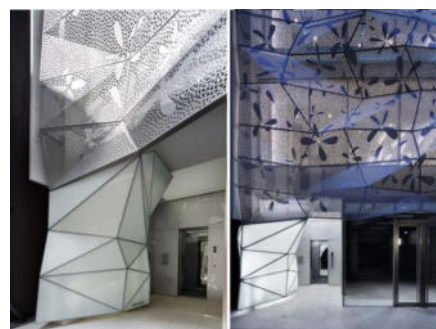
Figure 33: détails de la façade translucide (Source : www.archdaily.com )
