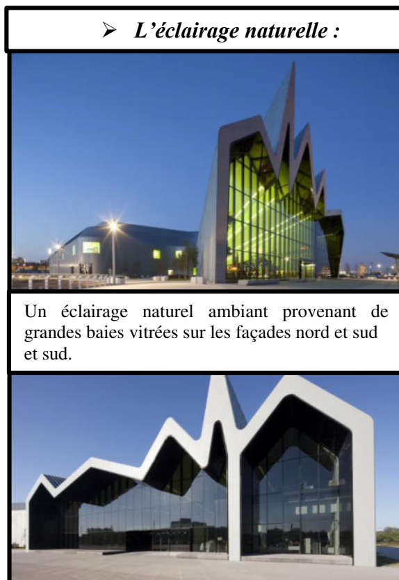
Figure 89: l'éclairage naturelle de musée (Source : www.archdaily.com )
