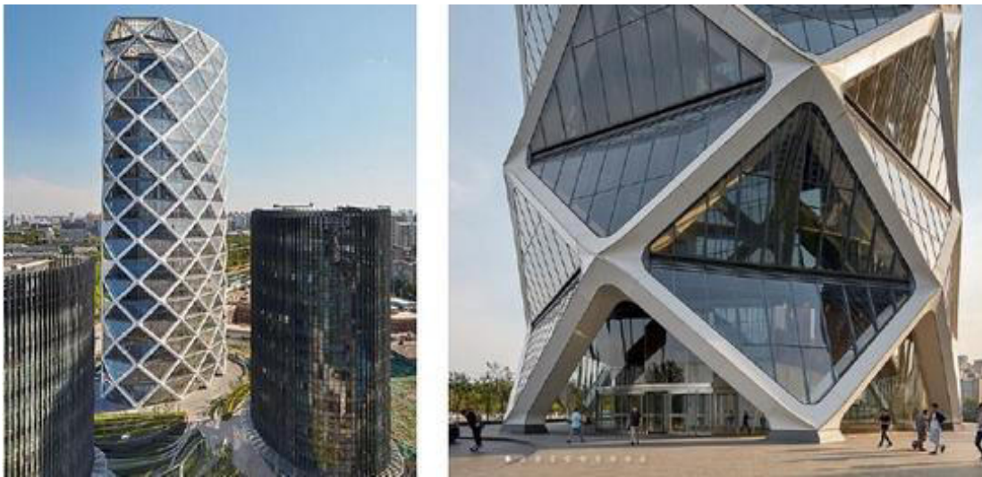
Figure 31: Poly International: façade complète pliée en Miura-Ori / diagrid structural incorporé à la façade (Source : https://www.slideshare.net/roopachikkalgi/shading-devices- )
