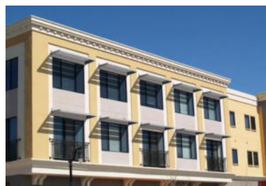
Figure 27: les brises soleil horizontales dans la façade sud de bâtiment (Source : www.archiexpo.fr )
