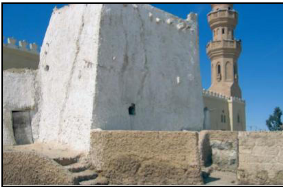
Figure -15 : À Siwa : tombeau du saint Sîdî Suleyman (architecture de terre blanchie à la chaux)
