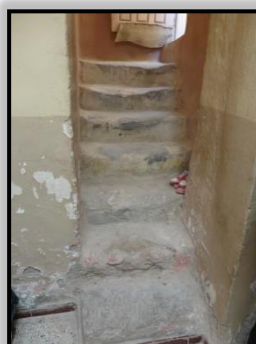
Fig. 46 : Photo d'escalier en L Source : Auteur 2018
