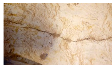
Fig. 128 : fissures capillaires Source : Auteur 2019
