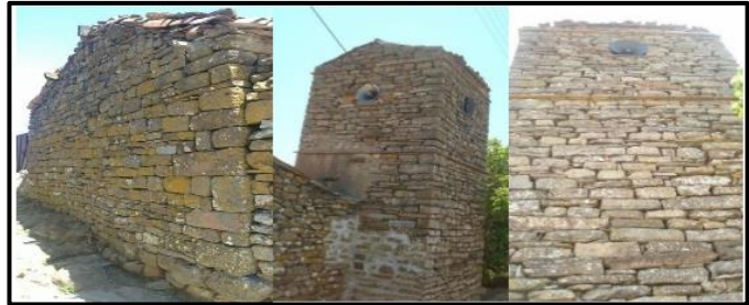
Fig.9 : Murs en pierres sèches. Village ancien, Azzefoun Source : ALLIA.S(2012)
