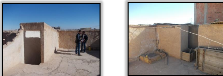
Figure 45 : Vues de la terrasse Source : auteur 2019
