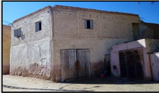
Fig. 71 : Vue du face latérale et postérieure de la Demeure Source : Auteur 2019
