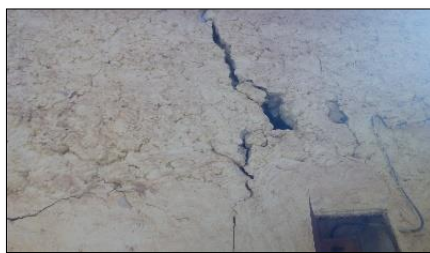
Fig. 136 : Fissures passantes Source : Auteur 2019
