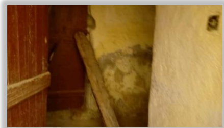
La porte d'escalier
