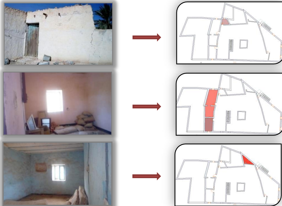
Fig. 85 : les pièces de la Terrasse Source : Auteur 2019.
