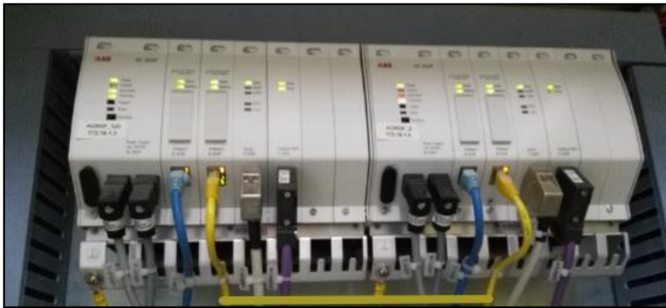
Figure 2.6: Redondance de contrôleur AC 800F
