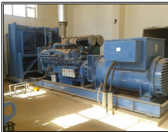
Figure 1.8 Générateur turbo diesel
