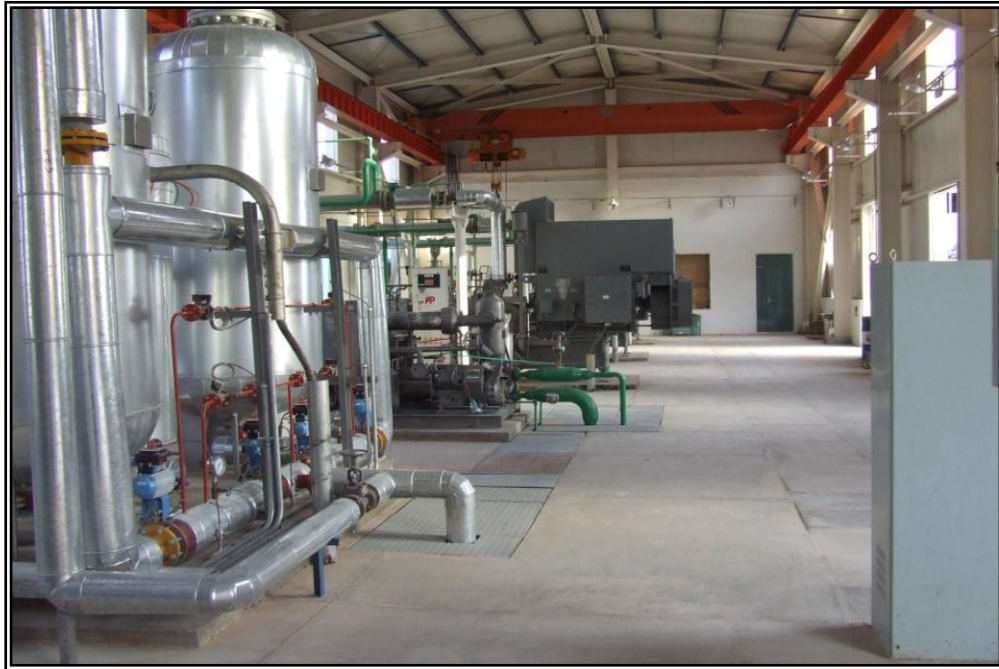
Figure. 1.11 Unité d'air comprimé
