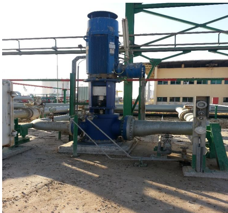
Figure I-10 : groupes électropompes boosters.
