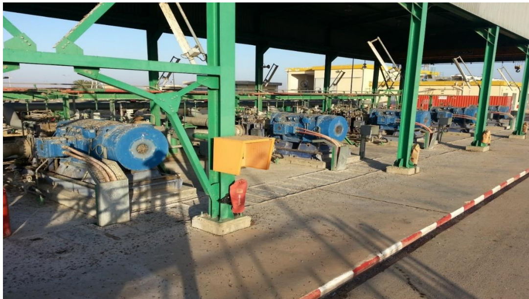
Figure I-8 : Groupes électropompes principales.
