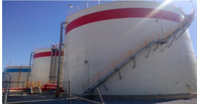
Figure I-7: Réservoirs d'eau d'incendie.
