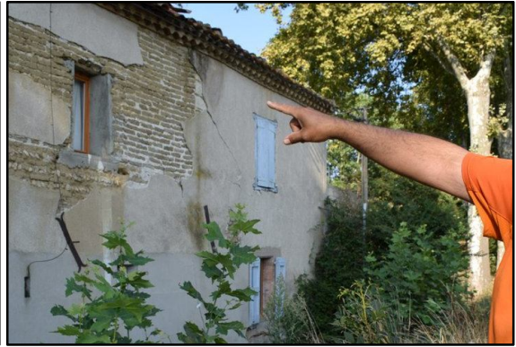
Figure I-17 : L'effet de l'affaissement de sol : Plantation d'arbre. [15]
