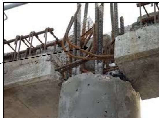
Figure I-29 : Ferrailages trop courtes et Manque de ferrailage
