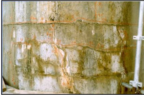
a. Réaction sulfatique interne
