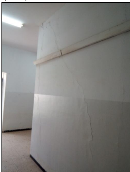
-c- Fissure oblique : Face extérieur de paroi
