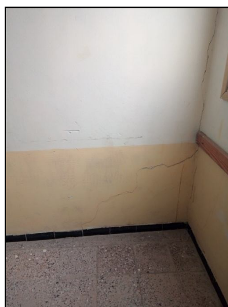
-d- Fissure oblique dans un mur intérieur : Coté arrière
