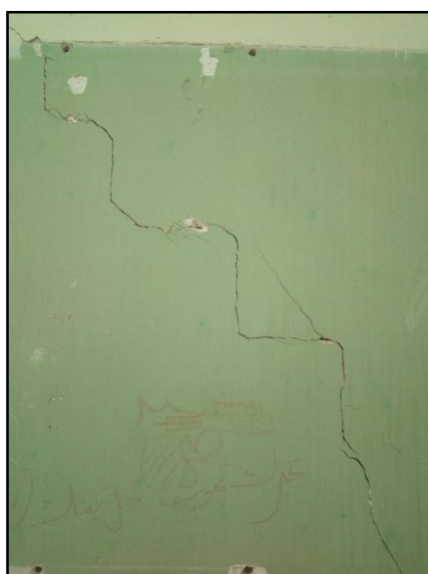
Cas (1 -H) -a- Lézarde dans un mur intérieur
