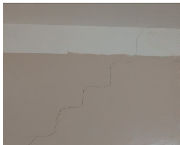
Cas (1 -A) -b- Lézarde dans un mur intérieur
