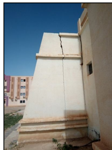
-b- Fissure vertical d'élément décoratif
