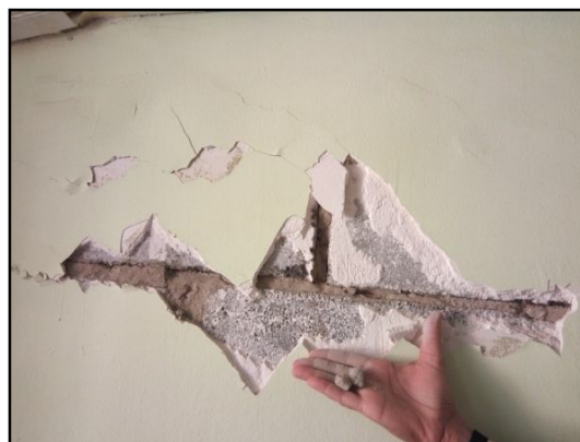
-d- Relevé in situ
