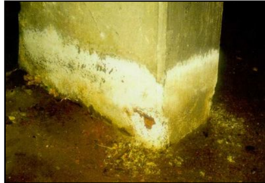
b. Réaction sulfatique externe
