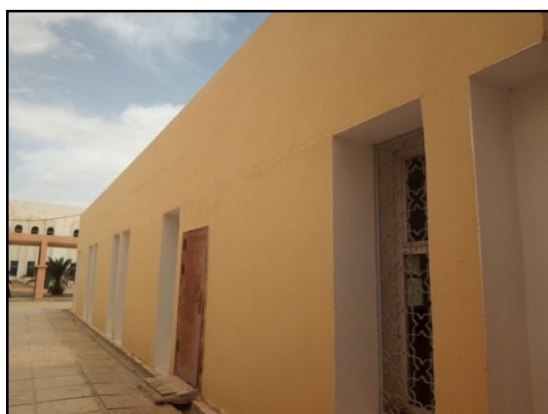
Cas (1-K)-a- Fissure à la long d'emplacement de port à faux
