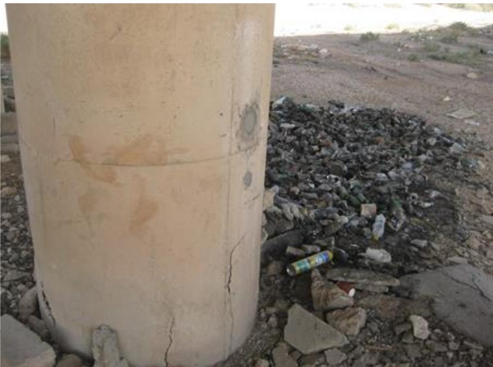
Figure 16 : Fissuration des piles
