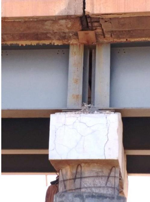
Figure 20 : les joints de chaussée ne sont pas étanches
