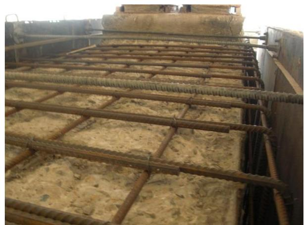
Figure 22 : Bouchardage et renforcement du chevêtre
