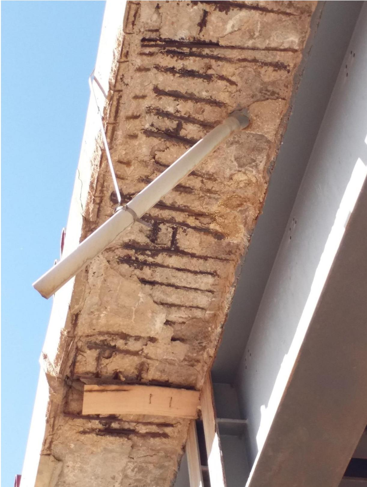
Figure 17 : dégradations des trottoirs.
