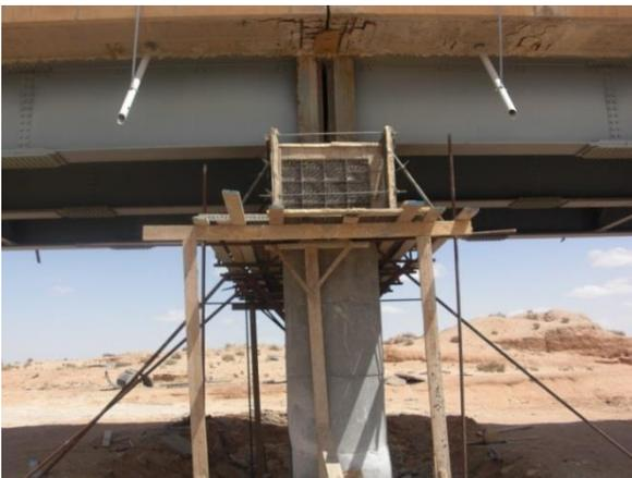
Figure 21 : Préparation de la surface des chevêtres
