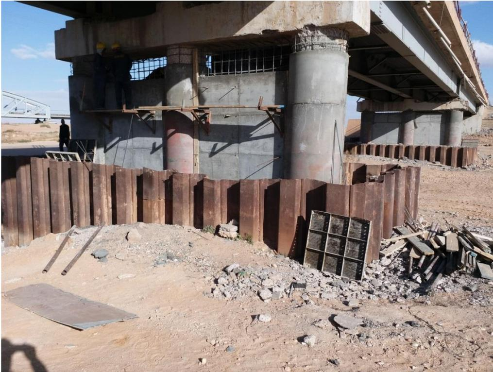
Figure 15 : les palplanches forment des quais sur les semelles
