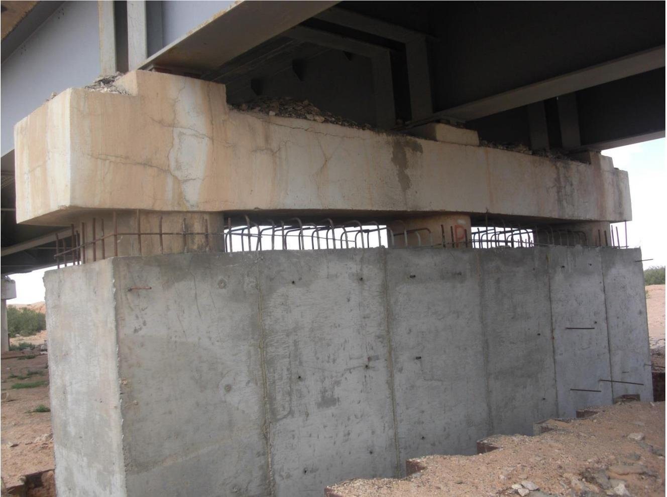
Figure 25 : Renforcement par voile.
