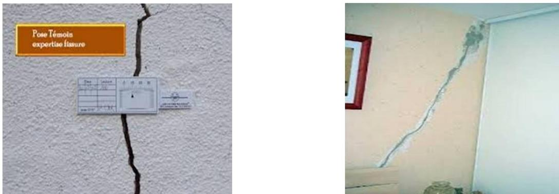
Figure 6: Fissure de béton
