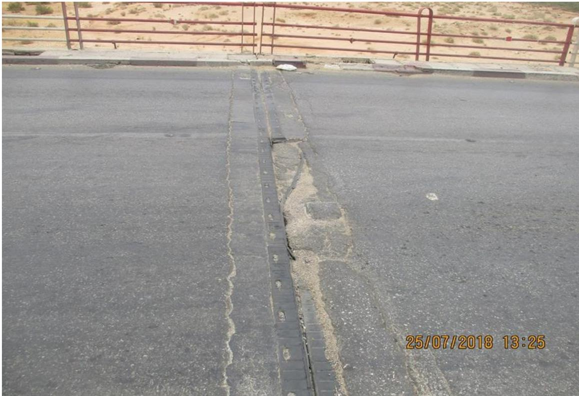
Figure 19 : joints de chaussée dégradée
