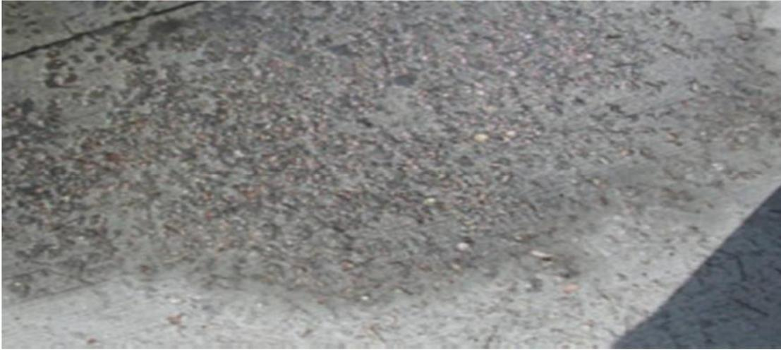
Figure 2 : Dégradation due aux sels de déverglaçage
