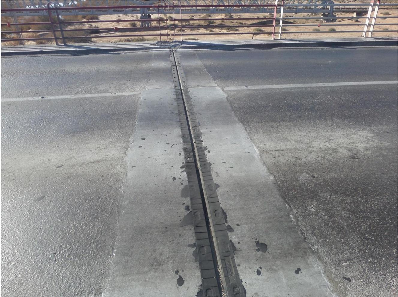
Figure 27 : Remplacements les joints de chaussée
