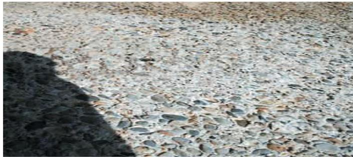
Figure 23 : Aspect d'une surface en béton ayant été soumise au phénomène de lixiviation
