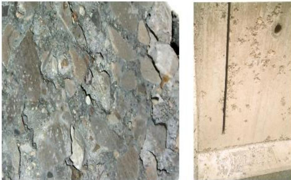
**Figure 22** : Phénomène d'attaque gel-dégel
