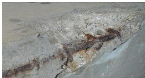
**Figure 20 :** Exemple de carbonatation de béton
