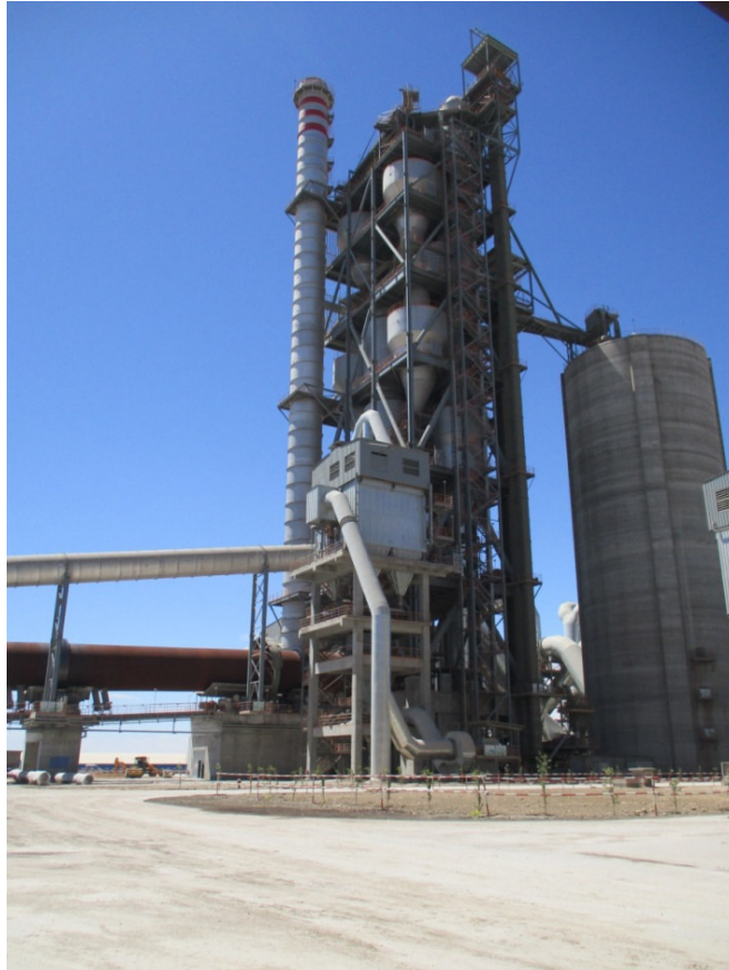
Figure I.11 La tour de préchauffage
