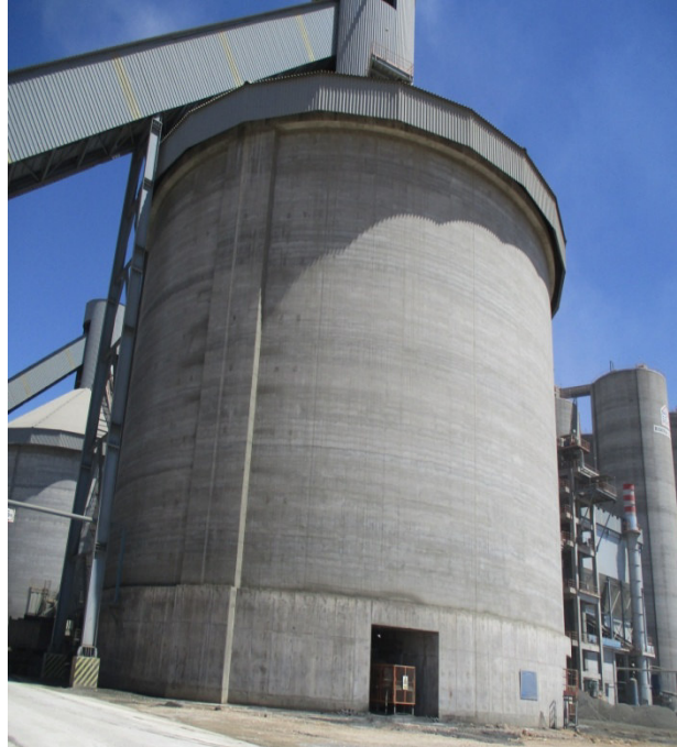
Figure I.15 Un Silo de stockage de clinker
