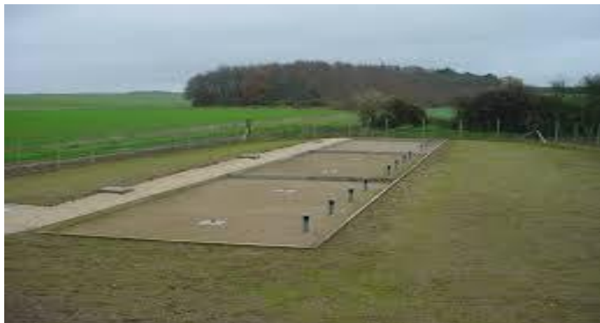
Figure III.3: le procédé d'infiltration-percolation en échelle réelle.
