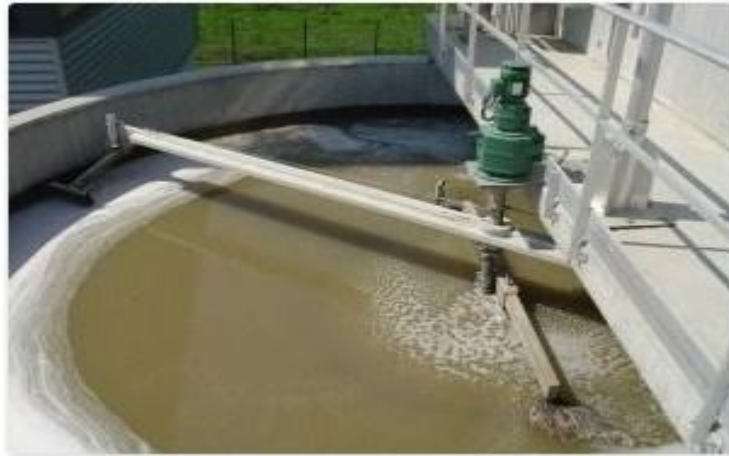
Figure III.2 : Dessablage et Déshuilage
