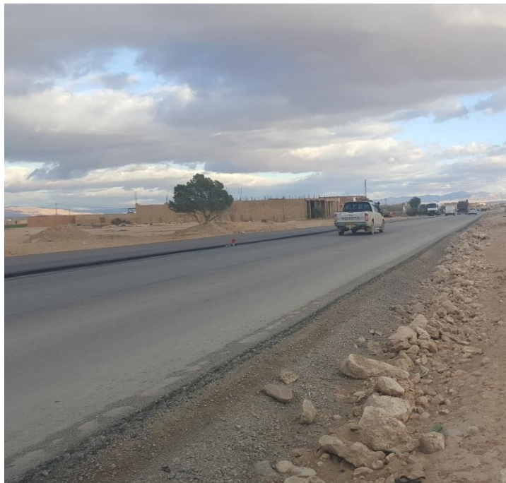
Figure 1 : photo réelle du projet
