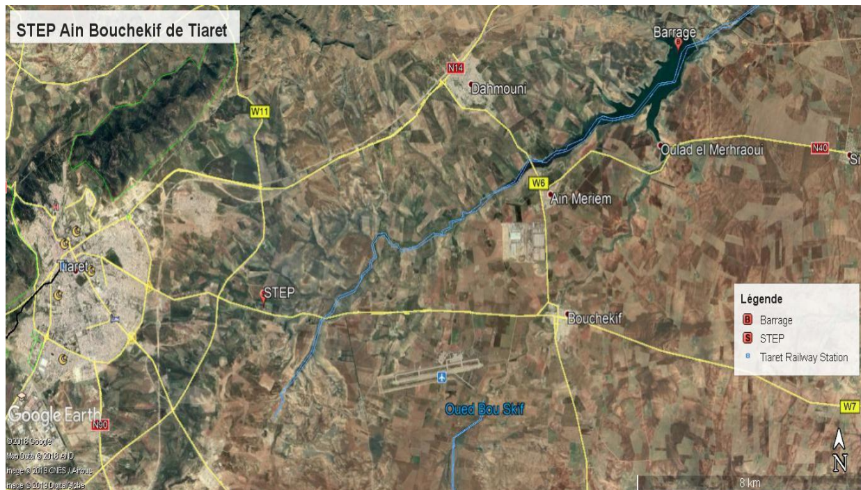
Figure n°17 : Station épuration Ain Boucekif de Tiaret (mai 2019).
