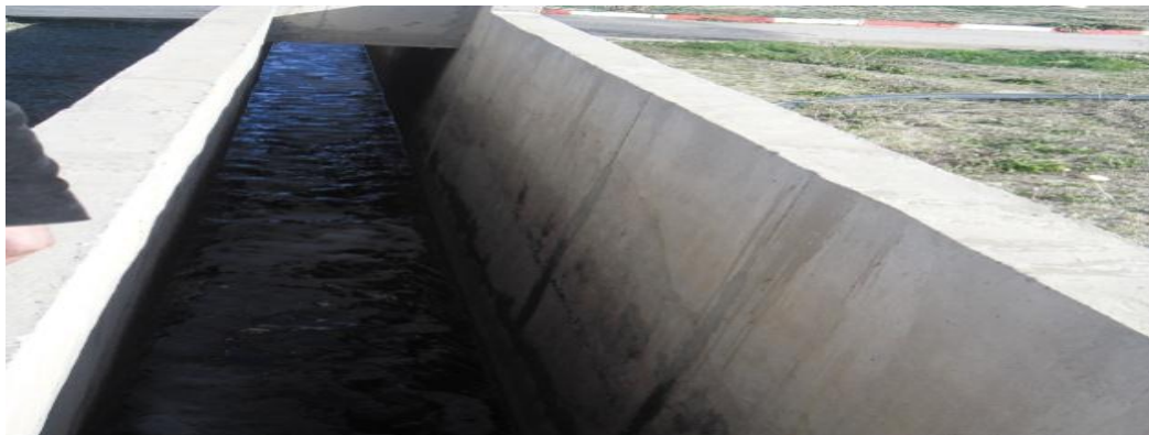
Figure n°26 .Canal de rejet
