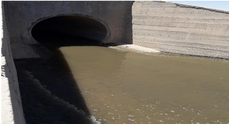
الشكل 17: مصب مياه الصرف الصحي المنزلي (منطقة لبشاش)
