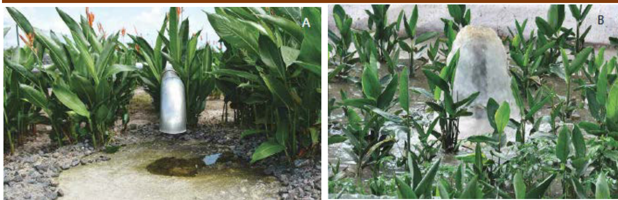
Figure 1.9 : Réseau d'alimentation aérien avec la plaque anti-affouillement (à gauche), ou enterré lors d'une bâchée (à droite) (Lombard et Molle, 2017).
