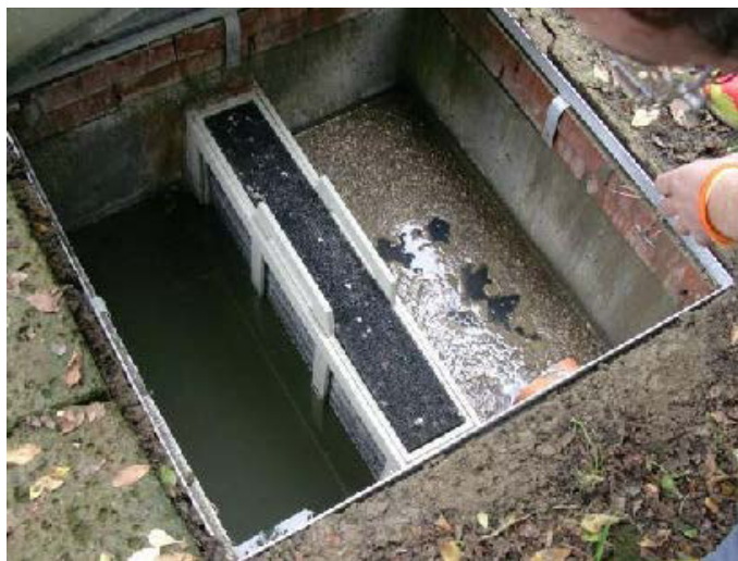
Figure 3.22 : filtre de finition (Abebsi,2011).
