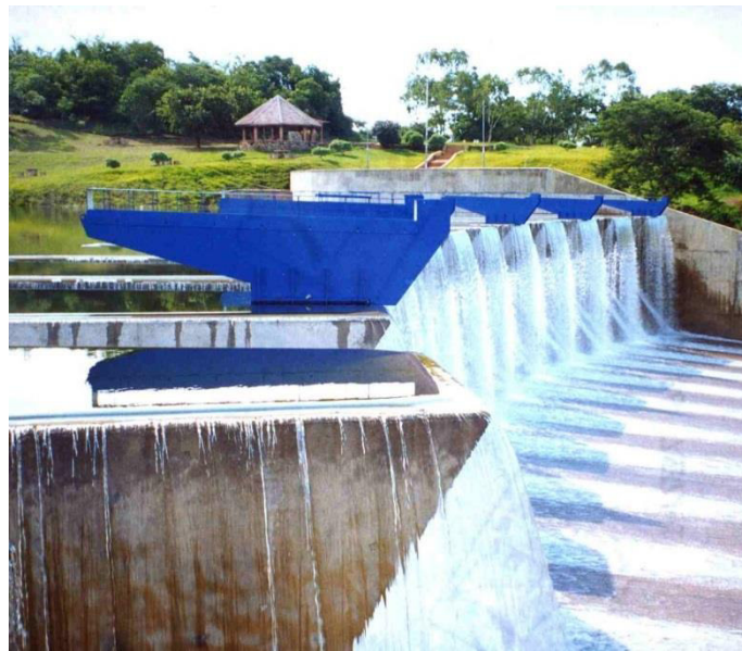
Figure I.10 Puits d'alimentation solidaire de la hausse (en acier)
