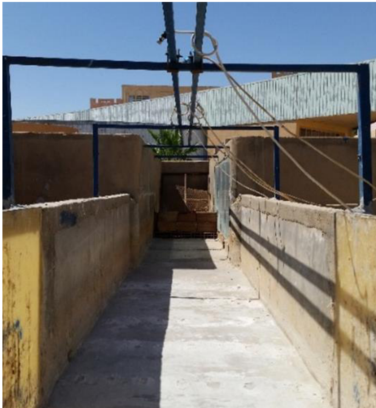
Figure III.2 Vue aval du canal des essais de la station d'expérimentation.
