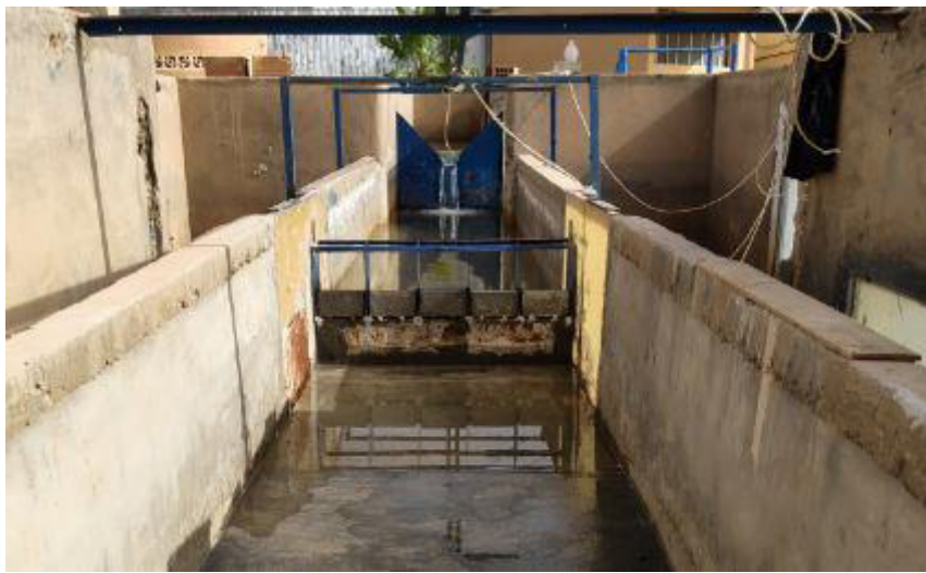
Figure III.12 Vue aval des blocs posés sur les pertuis
