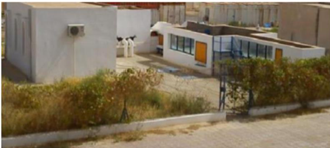
Figure III.1 Vue d'ensemble de la station d'expérimentation.
