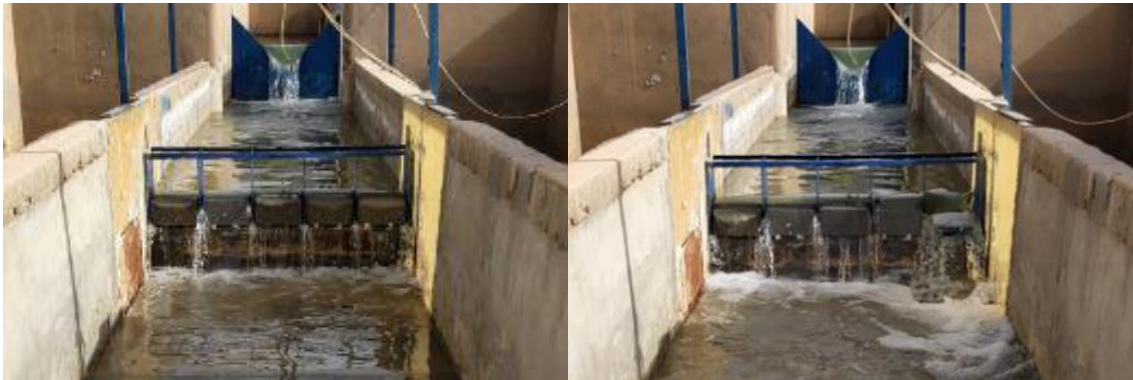
Figure III.14 Déversoir avant et après le basculement d'un bloc fusible
