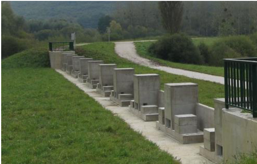
Figure I.45 Déversoir digue fusible (France)
