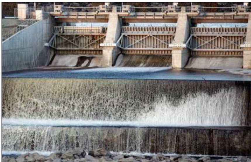
Figure I.48 Barrage Milner avec les murs en L –USA
