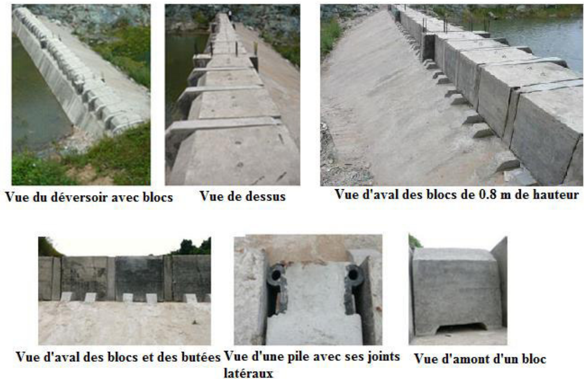
Figure I.28 Blocs fusibles sur un seuil avec des murs séparateurs
