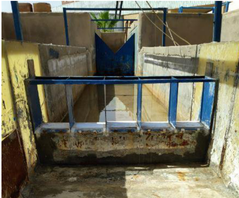
Figure III.11 Socle de basculement des blocs
