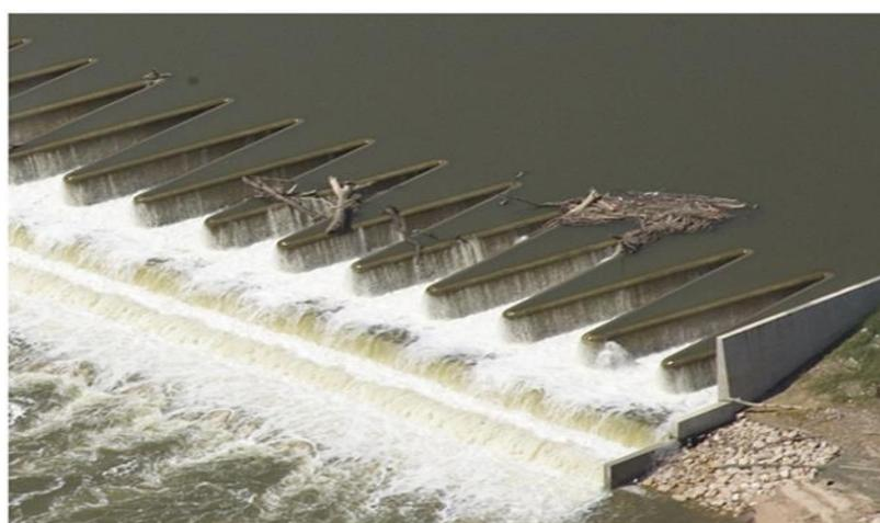
**Figure IV.04 : Déversoir en labyrinthe (barrage Texas, USA)**
