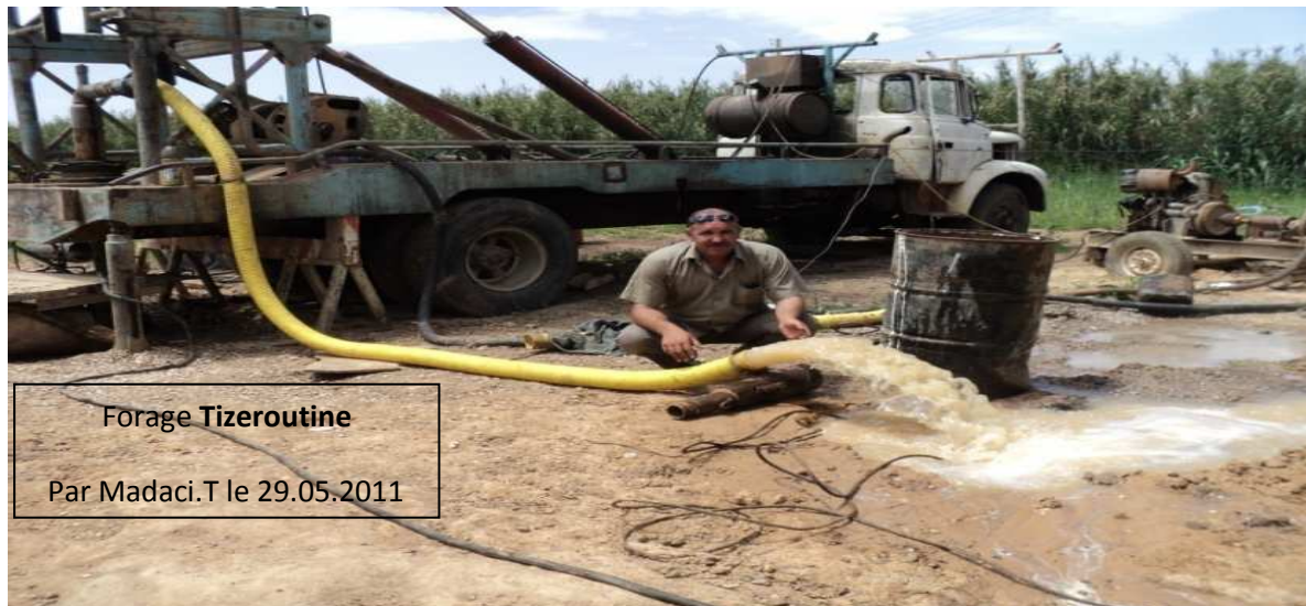
Figure 19 : Développement par pompage
