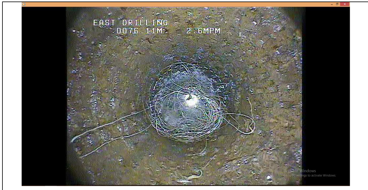
Figure 37 : Forage CHOUADI à 76 m
