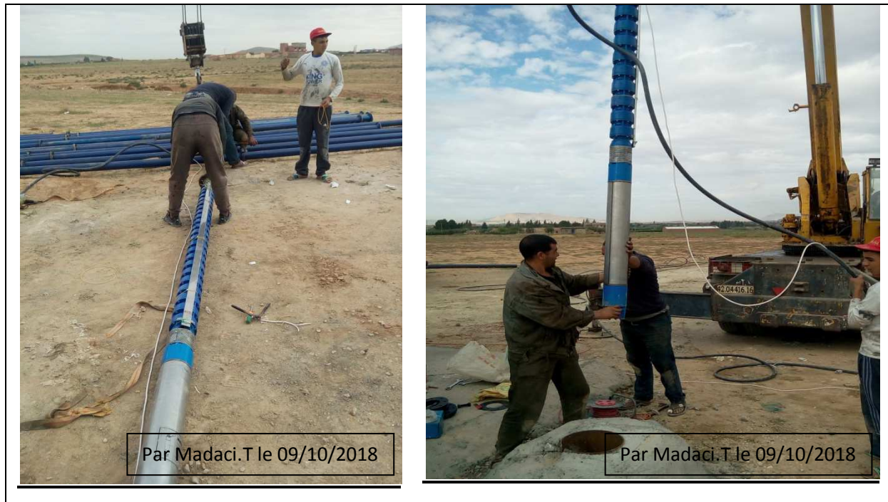
Figure 23 : Démontage de la pompe
