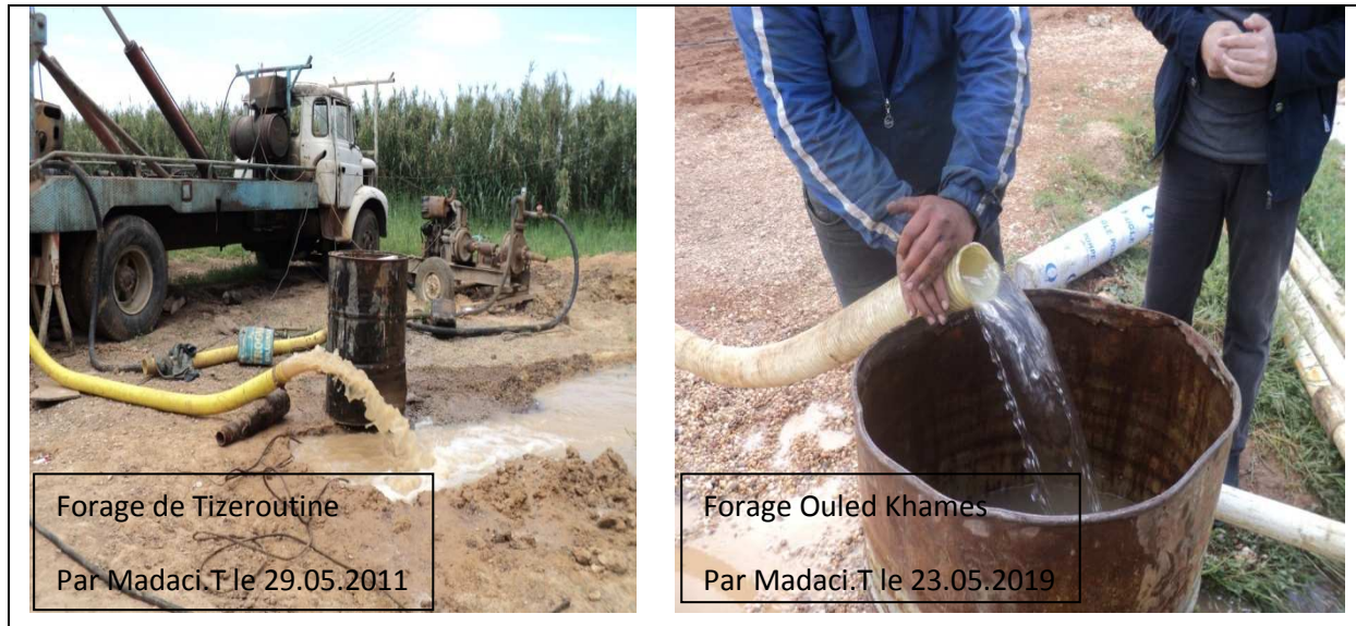
Figure 20 : Les essais de pompage
