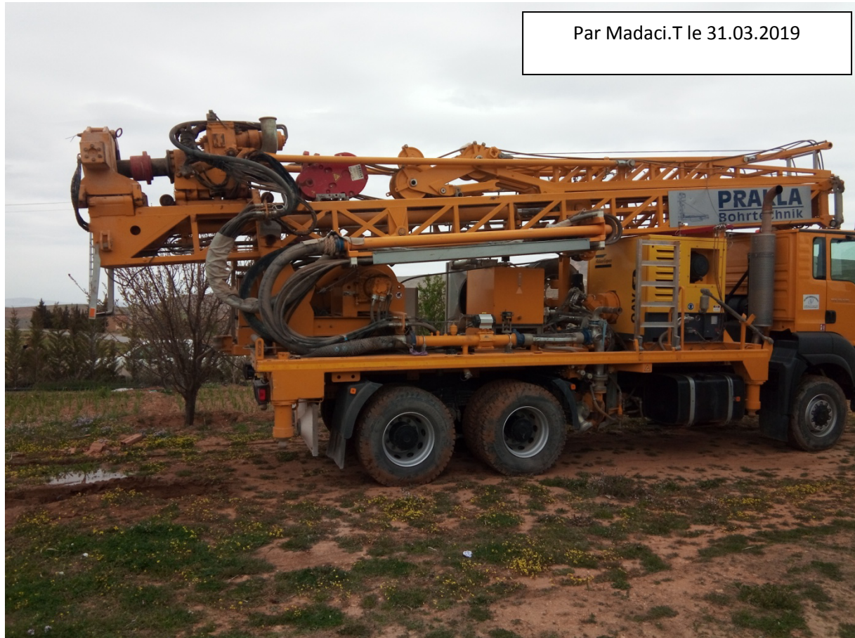
Figure 10 : Forage en circulation inverse
