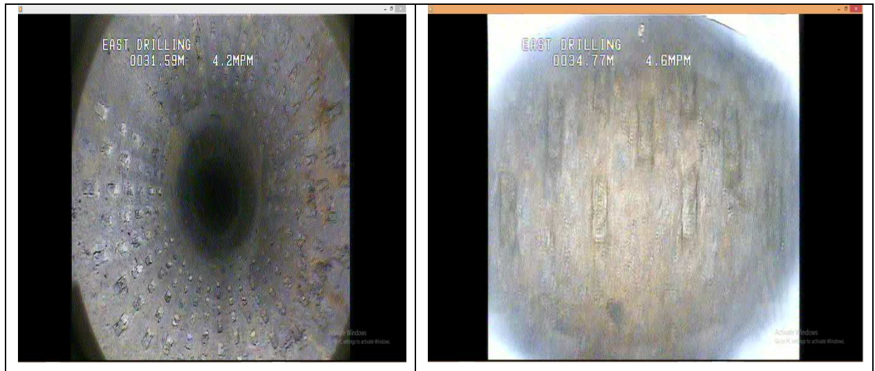
Figure 35 : Forage CHOUADI de 31m à 34 m
