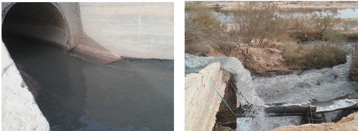
Photo I.9 : Le rejet des eaux usées.
