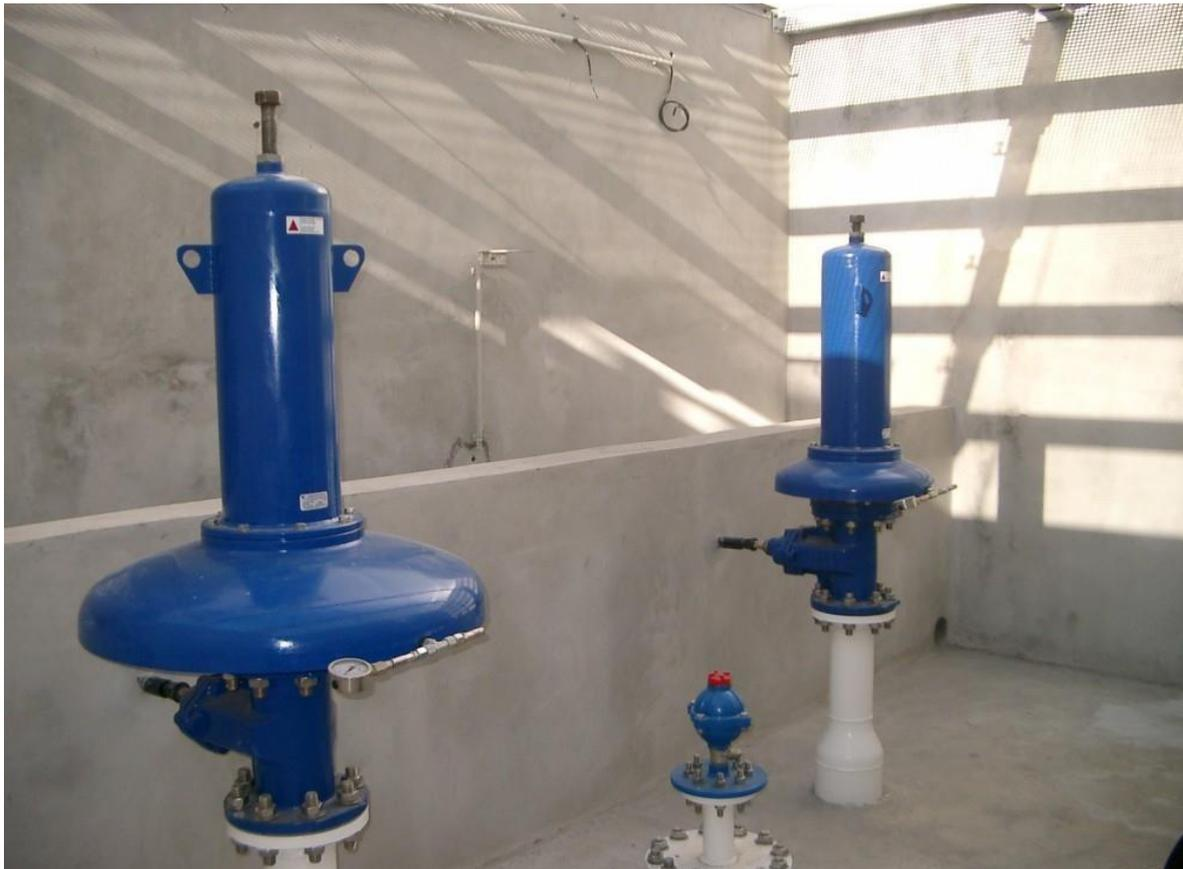
**fig.III-14 : soupapes des décharges Ramus**
