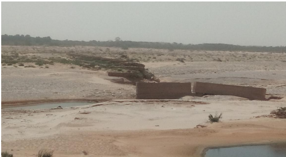
1- Photo N °5: Le corps de barrage ( LAHLALI.A, 2019)
