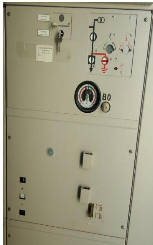
Figure III.23 : Disjoncteur SIEMENS [13].
