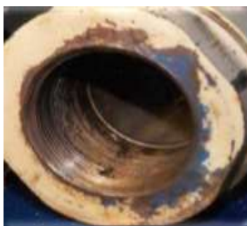
Figure (I.2): Corrosion galvanique au niveau d'une zone de brasage entre la brasure Cu-P et le tube en cuivre.
