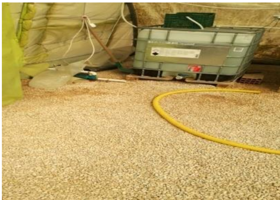
- Figure 13 : évacuation d'eau - (original)
