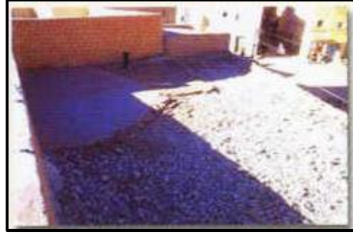
الصورة 2. توضح سطح أحد المساكن المراد ترميمها
