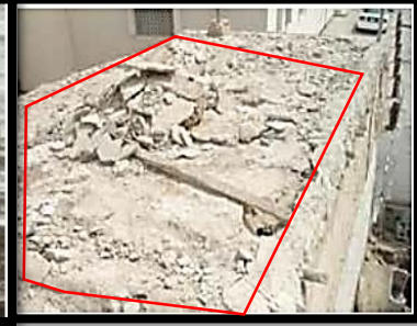
الصورة 17: توضح إزالة الطبقات المضافة أعلى سطح الاسقف لتخفيف الوزن
