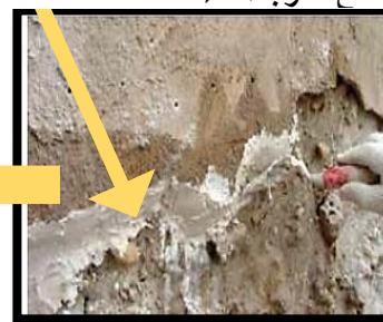
الصورة 35: توضح عملية سد الأطراف السفلية من طبقتين الملاط لمنع تسرب الماء
