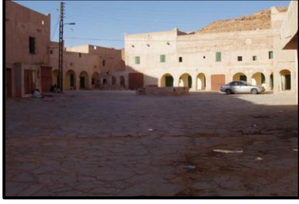
الصورة 52: توضح الواجهة رقم 02
