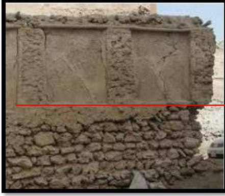
الصورة 10: توضح أسلوب بناء الجدران
