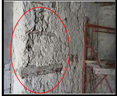
الصورة 15: توضح مظهر الجدران بعد إزالة طبقات الاسمنت البورتلندي
