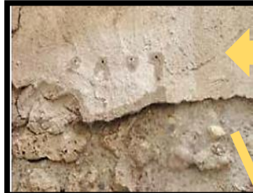
الصورة 36: توضح عملية حقن المونة
