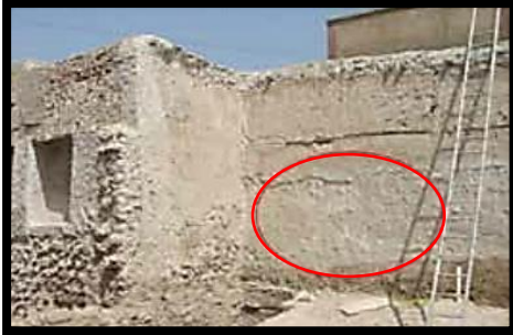
الصورة 31: توضح عملية استكمال طبقات الملاط المفقودة ويظهر سمك الطبقة
