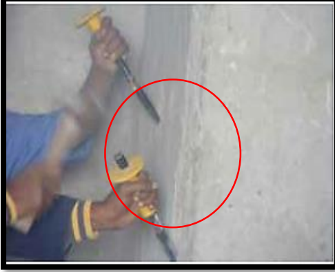
الصورة 16: توضح عملية إزالة طبقات الاسمنت البورتلندي
