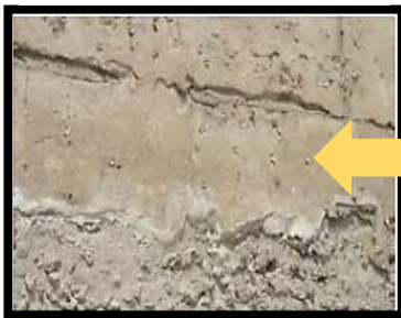
الصورة 37: توضح مظهر طبقة الملاط بعملية الحقن والتثبيت
