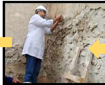
الصورة 36: توضح عملية حقن المونة
