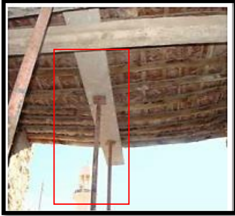
الصورة 14: توضح عملية تدعيم السقف
