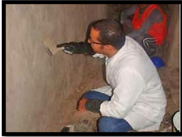
الصورة 37: توضح مظهر طبقة الملاط بعملية الحقن والتثبيت
