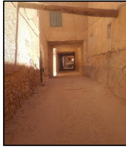
الصورة 71: تبيين ممر مغطى بحاجة لتقوية الدعامات قبا التدخل
