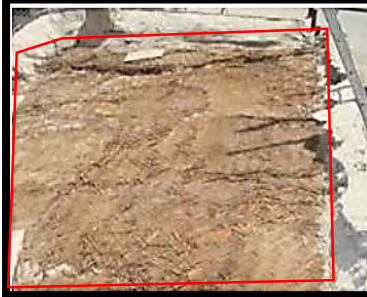
الصورة 19: توضح مظهر السقف بعد إزالة طبقات الاسمنت المضافة
