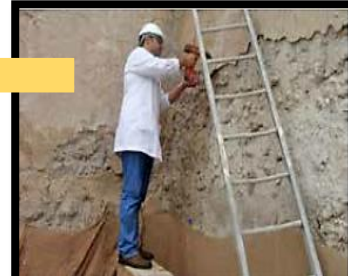
الصورة 35: توضح عملية سد الأطراف السفلية من طبقتين الملاط لمنع تسرب الماء
