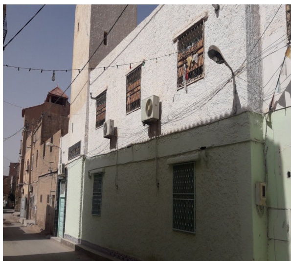
Figure12 : la façade de la mosquée SIDI DJOUDI
