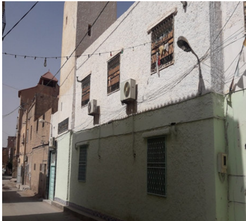
Figure 7 : la façade de la mosquée SIDI DJOUDI
