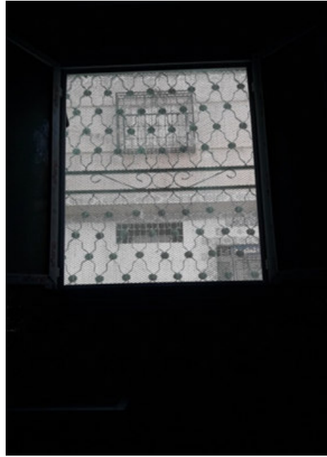
Figure 9 : fenêtre de la mosquée de Sidi Djoudi
