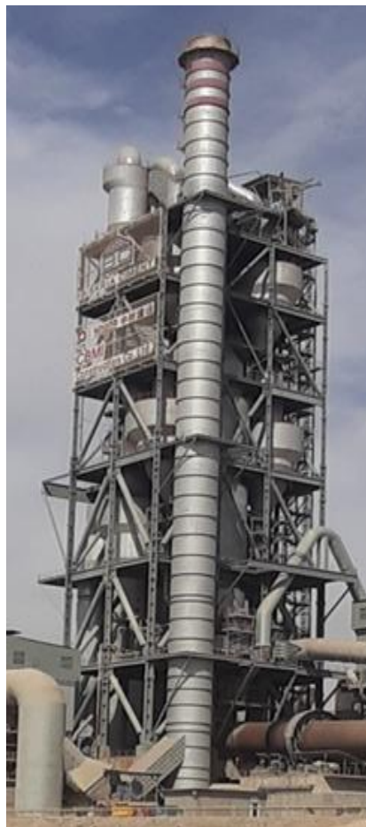
Figure III.7.La tour de préchauffage
