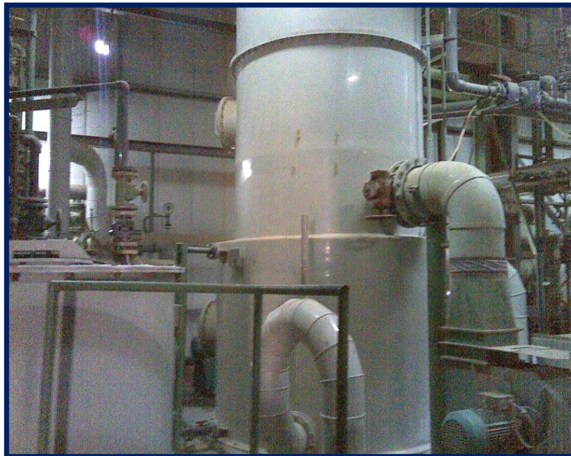
Figure IV.5 : Dégazeur (TIFIB)
