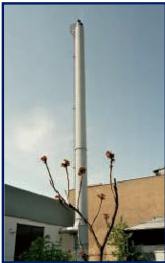
Figure II.8 : Photo d'une cheminée
