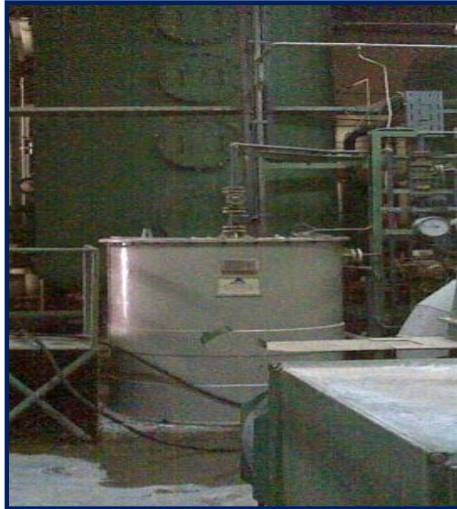
Figure IV.6 : Bac de solution de régénération
