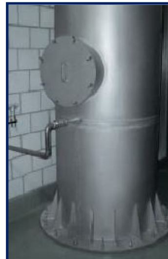
Figure II.9 : Photo d'un Pied de cheminée
