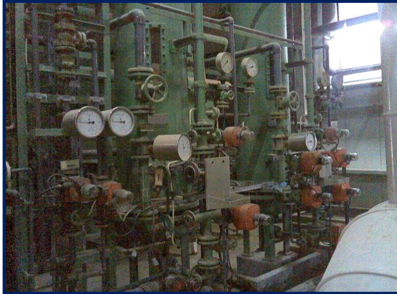
Figure IV.4 : Les deux échangeurs d'ions cationiques (TIFIB)
