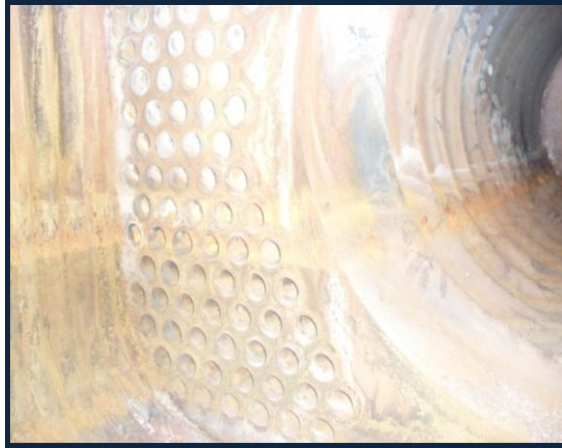
Figure II.6 : Les tubes de fumées
