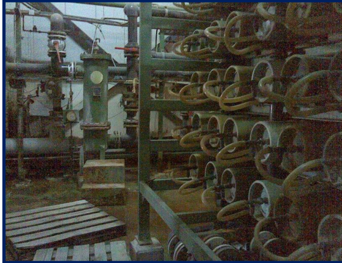
Figure IV.2 : Filtre à cartouches relié avec un bloc d'osmose inversée (TIFIB)
