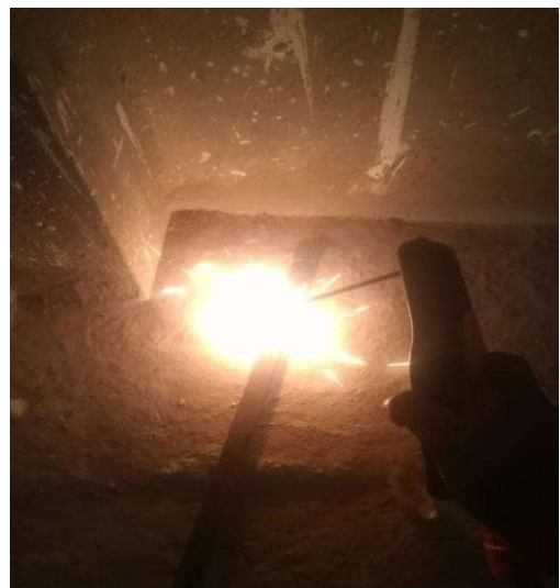
Fig. 16. : Poste à soudeur réalisé
