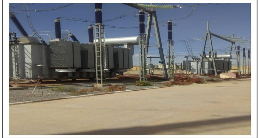
Figure II-19-Transformateur de puissance [17]
