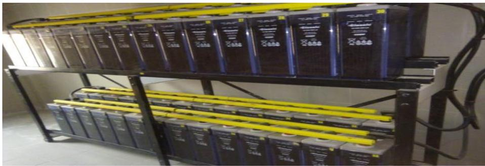
Figure II -24- Les batteries à courant continu 127 Vcc [21]
