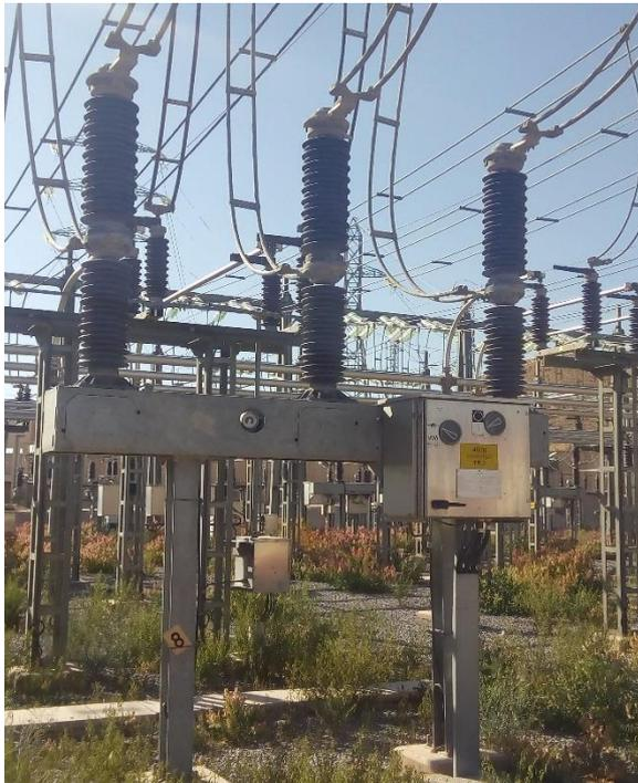
Figure II-13- Disjoncteurs 60kV [21]
