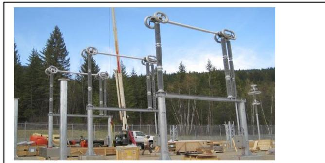
FigureII-15- Sectionneur à ouverture verticale [17]
