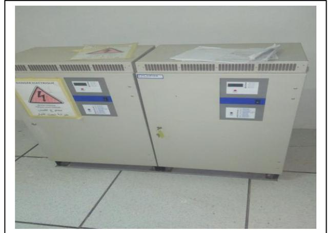
Figure II-23- L'alimentation des redresseurs 48 Vcc et 127 Vcc [21]
