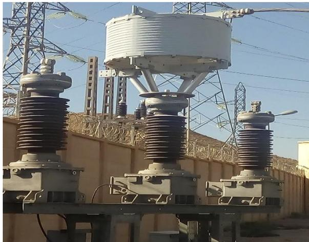
**Figure II-12-circuit bouchon [21]**
