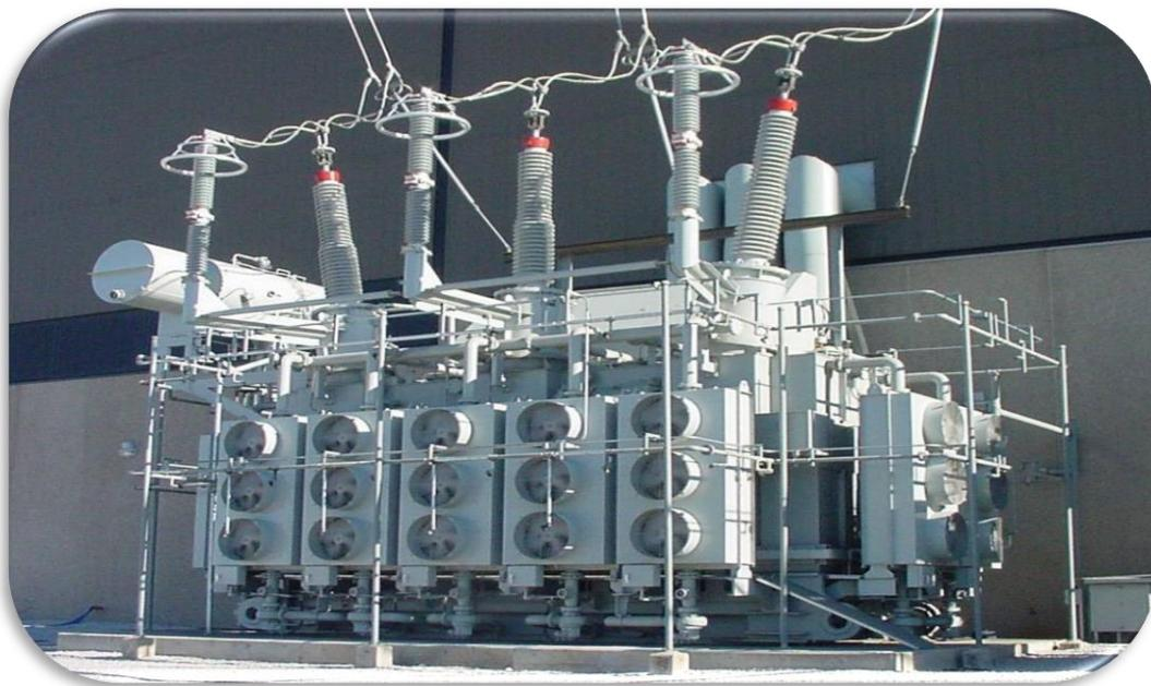
**Fig. I.1.** Transformateur élévateur de sortie de centrale électrique [6]
