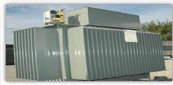
**Fig. I.11.** La cuve d'un transformateur de puissance [7]
