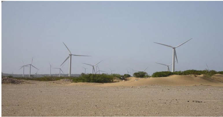
Figure I.9 : Parc éolien Amadou près d'Essaouira au Maroc
