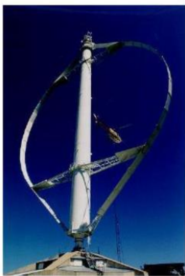
Éolienne de type Darrieus.
