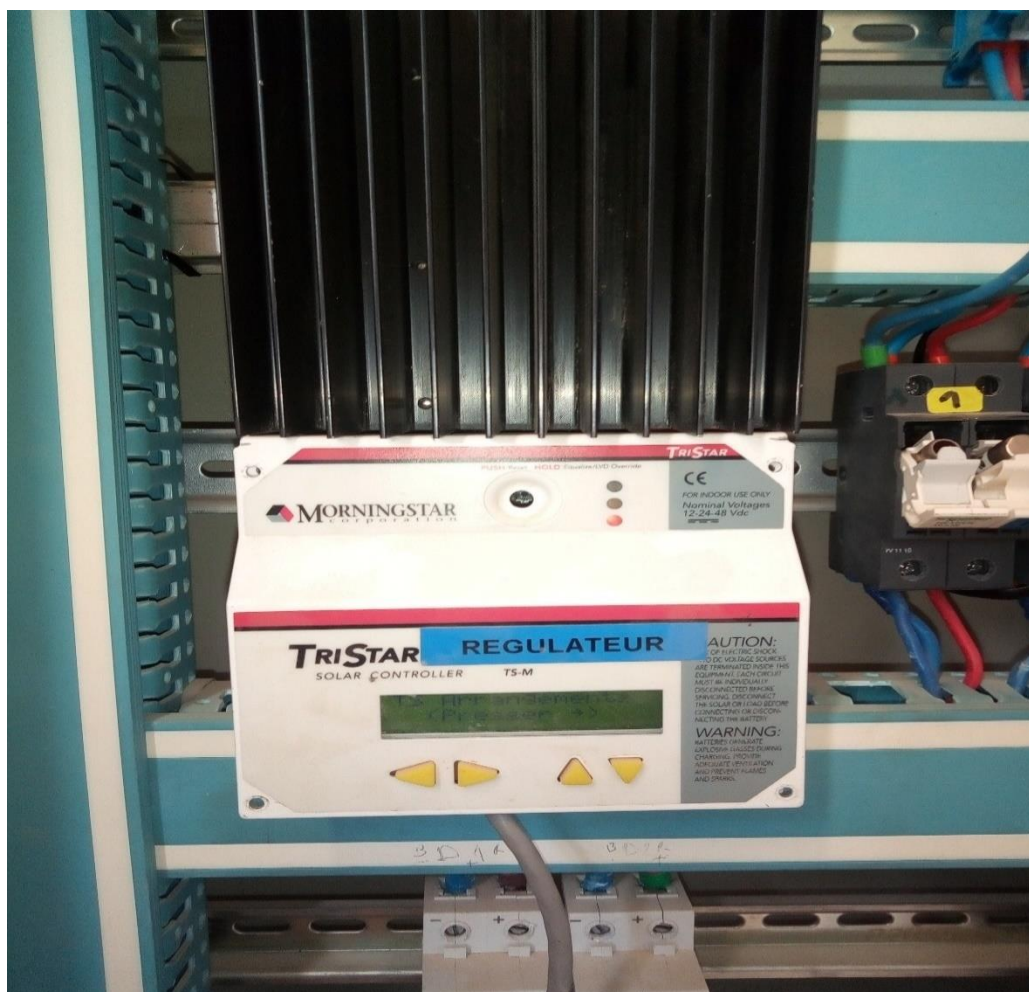
Figure 3.02 : Régulateur Morningstar (tristar TS60)
