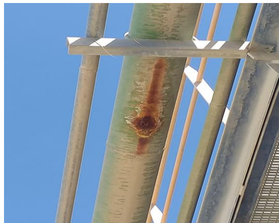
Figure (3.6) : Point de soudure dans un pipe d'eaux
