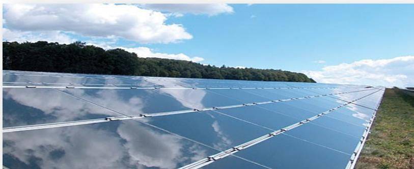
Figure 1.6: modules verre-verre au Telluride de Cadmium
