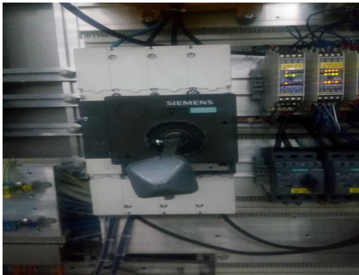
Fig.III.18. Disjoncteur sectionneur.
