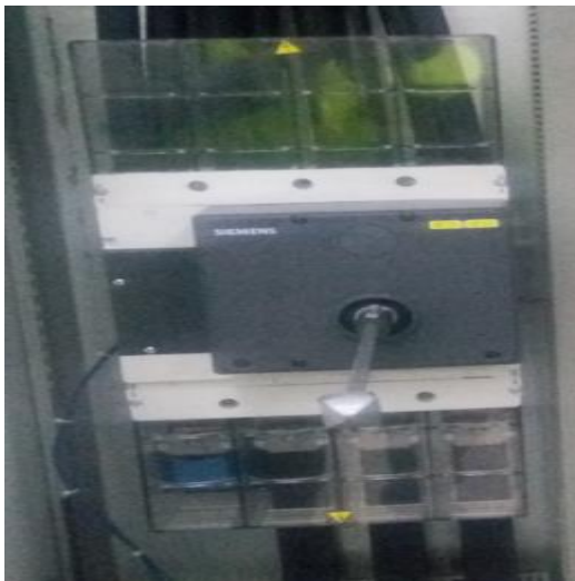
Fig.III.14. Disjoncteur sectionneur.
