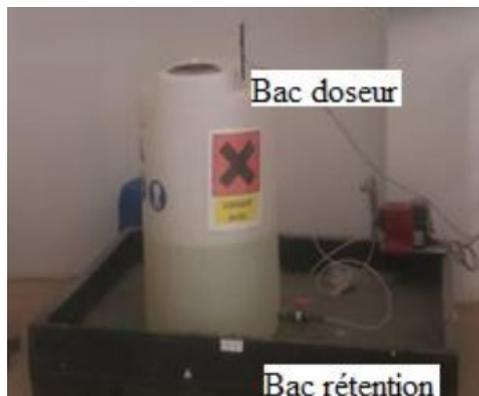
**Figure 1.17** Bac de doseur et un bac rétention.
