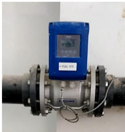
Figure 1.22: WATERFLUX 3000 avec IFC 100.
