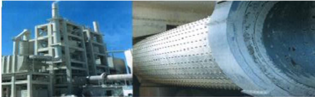
Figure I.8 : broyeur mélangeur cru[2]
