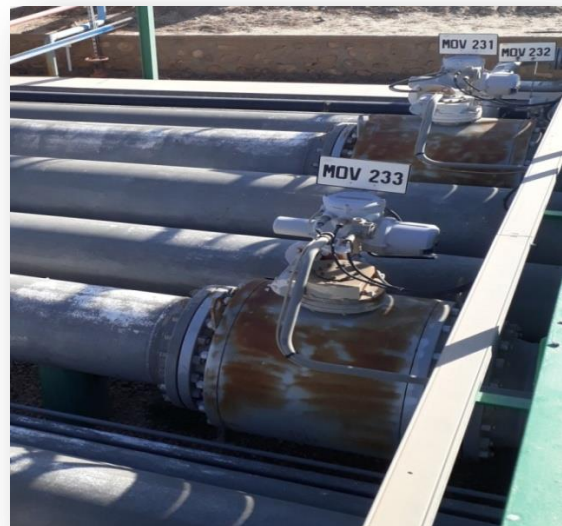
Figure. I.17. les électrovannes.
