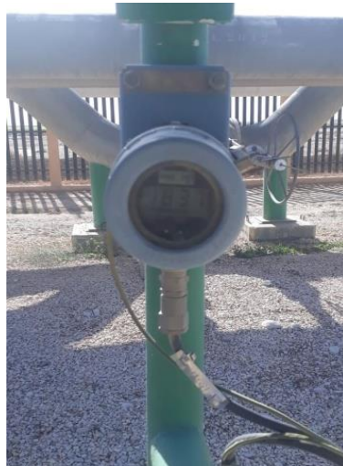
Figure. I.14. Débitmètre.
