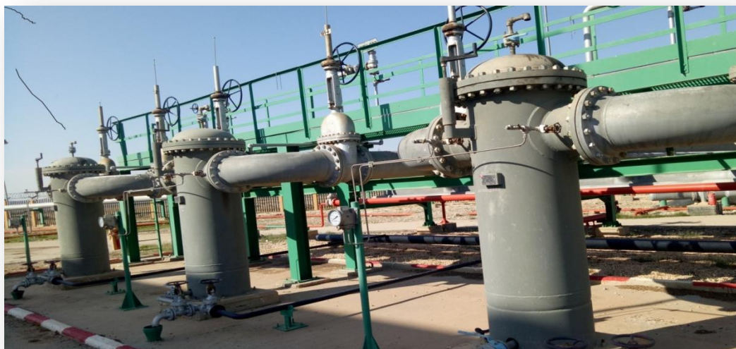
Figure I.6. les filtre.
