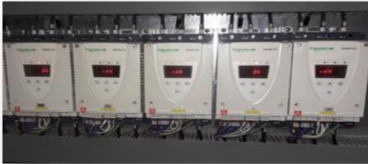
Figure. I.20. Les variateurs de vitesse.
