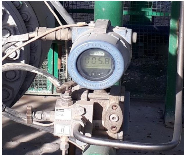
Figure. I.12. transmetteur de pression.
